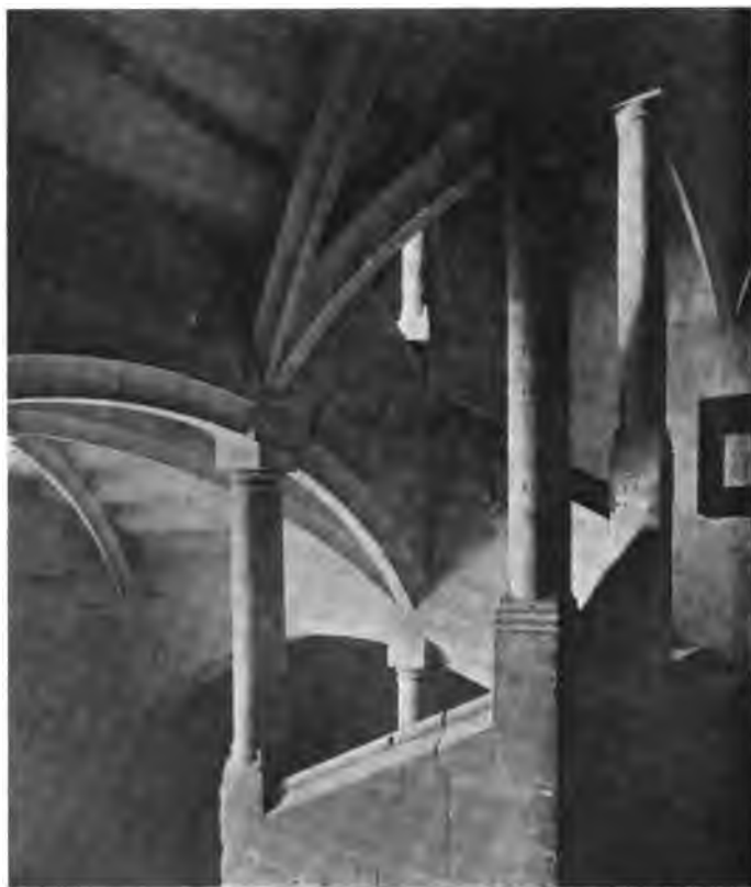
Fig. 109. — Escalier à cage évidée et colonnettes placées aux angles de la cage pour soutenir les arcs qui portent le limon. Ancien château, aujourd'hui Hôtel de Ville d'Aix-les-Bains.
